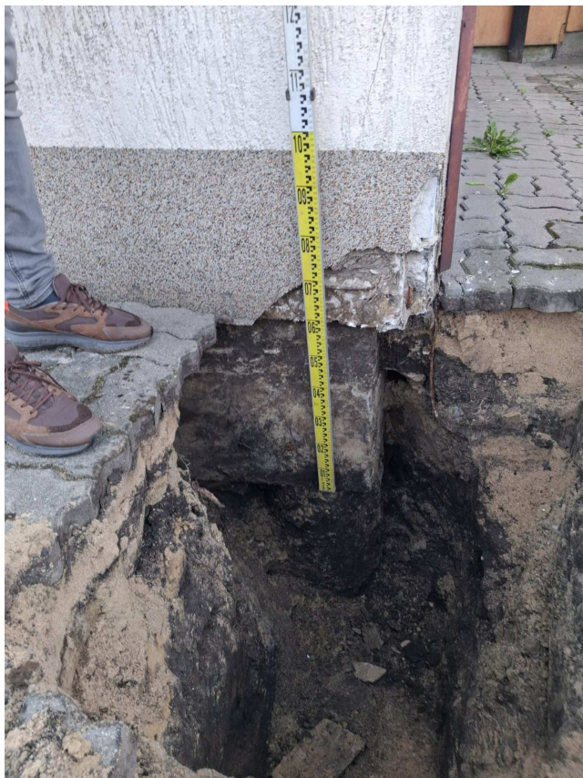
Fot. 5. Pomierzony oczep pala
