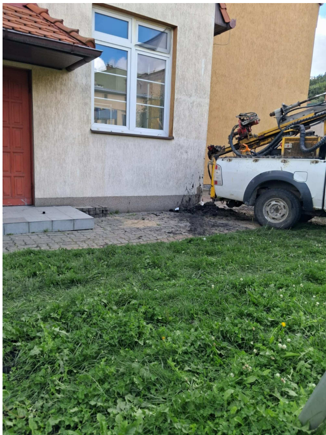
Fot. 1. Ściana północna budynku, przy otw. nr 1
