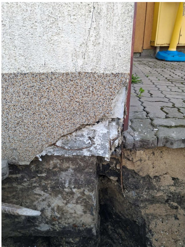
Fot. 3. Płyta fundamentowa i oczepek pala
