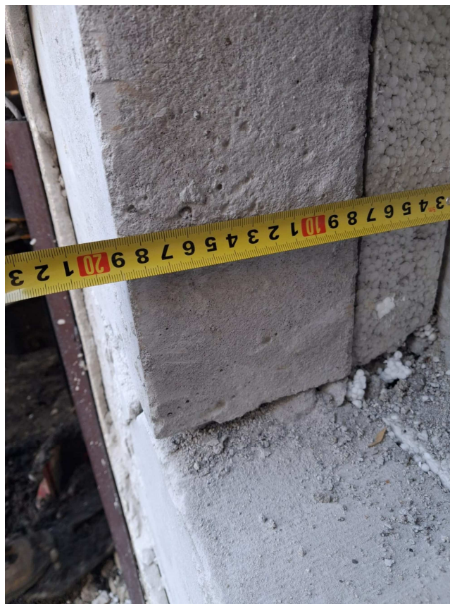
Fot. 8. Pomierzona ściana budynku od strony zachodniej
