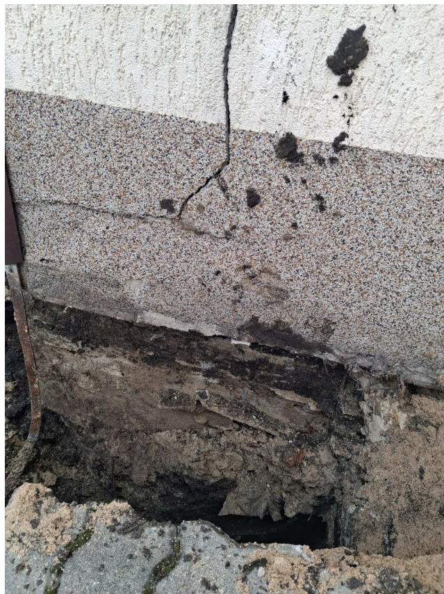
Fot. 6. Ściana, płyta fundamentowa i oczep pala od narożnika strony zachodniej
