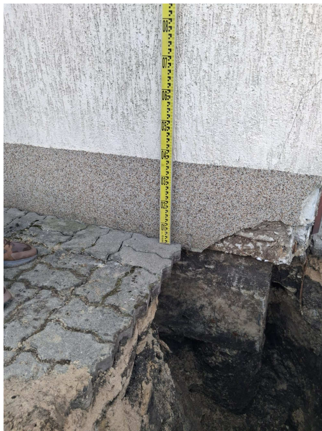
Fot. 4. Płyta fundamentowa i oczepek pala
